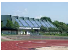
Ein Projekt mit der Stadt Marburg: Bürger Sonnenkraftwerk Georg-Gaßmann-Stadion
